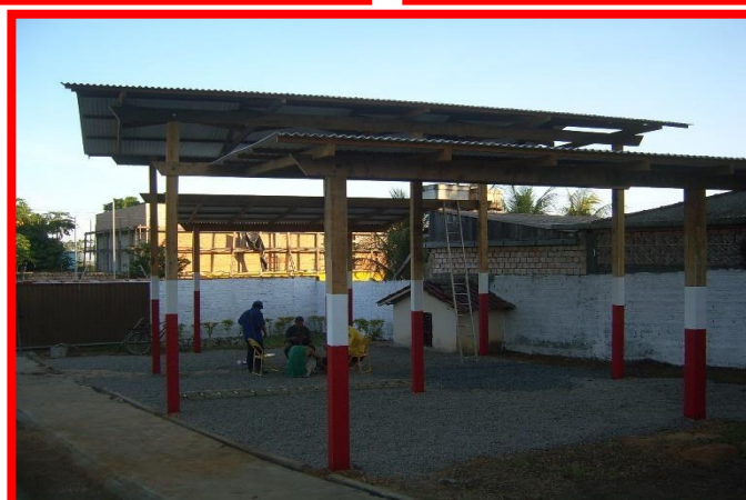
Construção da Garagem 2010
