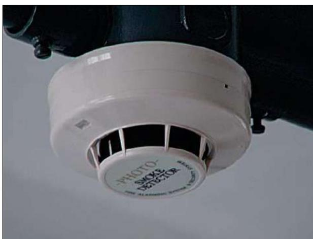
**Figura 41** – Detector de incêndio
