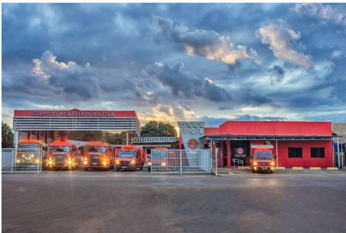
Instalações e viaturas do 1ºSGBM/5ºGBM e 5ºGBM (Ariquemes) 2019
