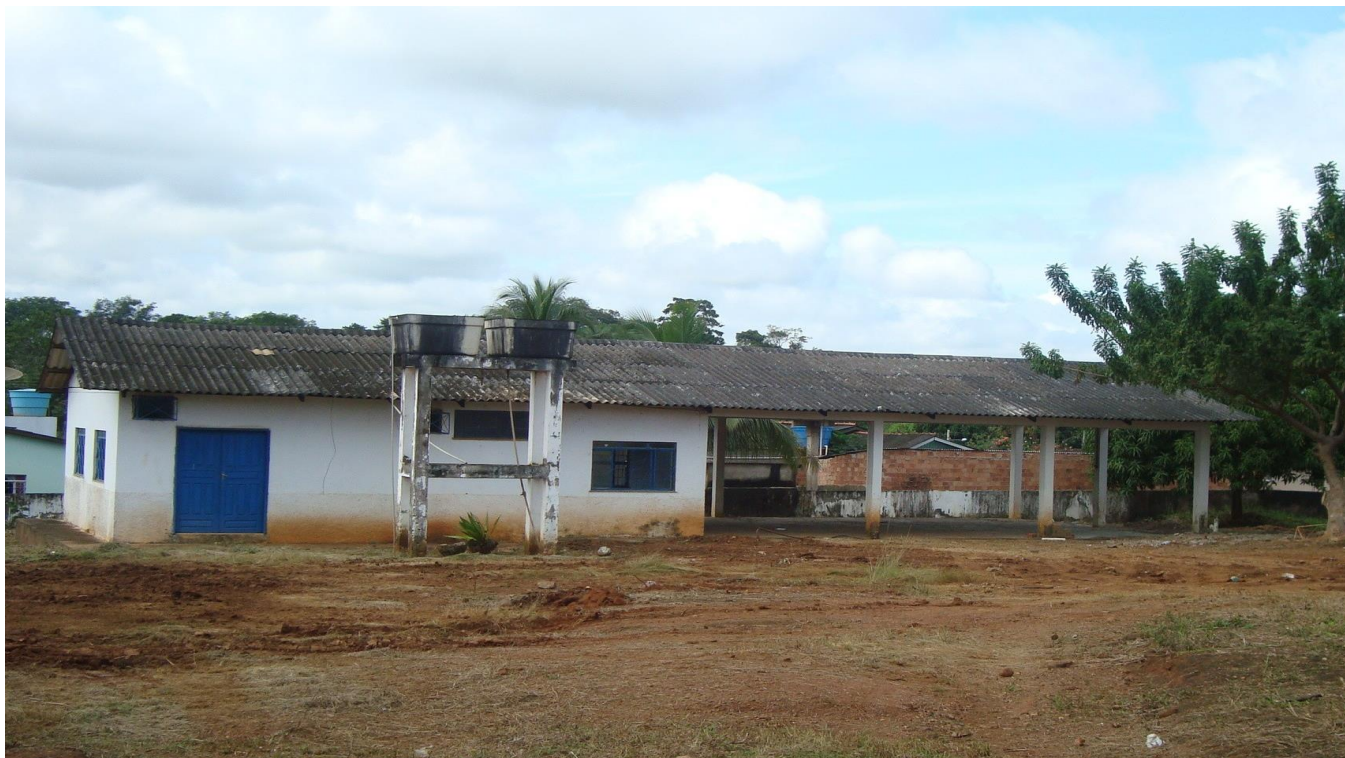
Início das obras para nova instalação do quartel na Rua ricardo catanhede, 617
