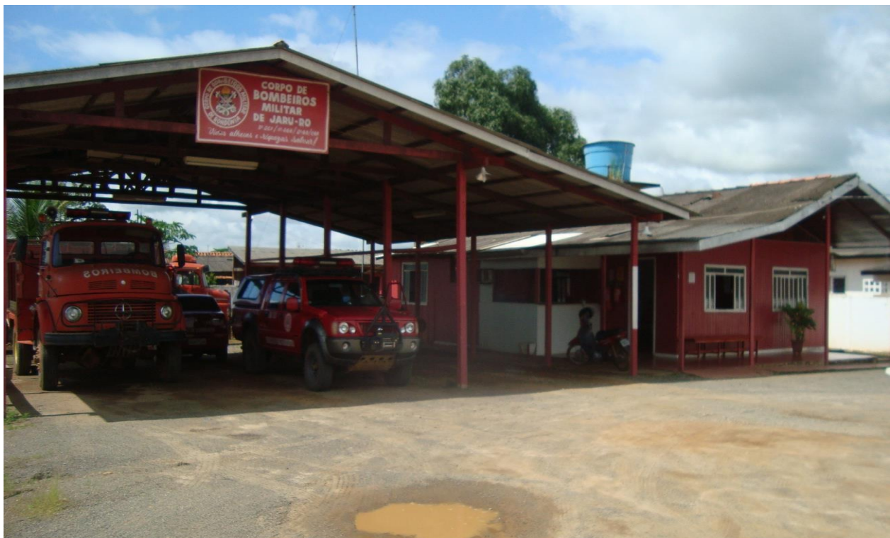
1ª Instalação, localizava-se na rua Florianópolis ao lado do atual prédio do IDARON
