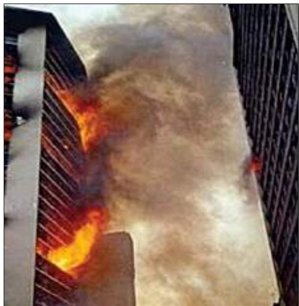
**Figura 14** – Propagação por convecção, em que gases quentes fazem com que ocorram focos de incêndio em andares distintos
