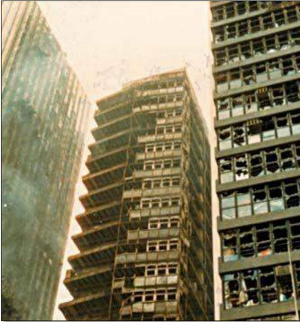
**Figura 15**– Radiação de calor de um edifício para outro
