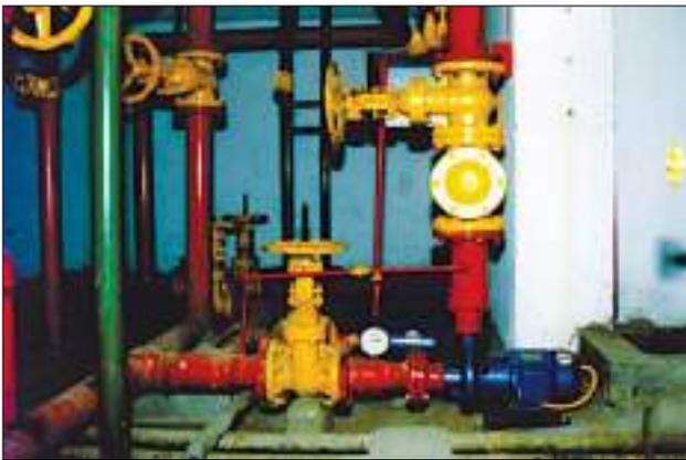
**Figura 50** – Bomba de incêndio e acessórios hidráulicos
