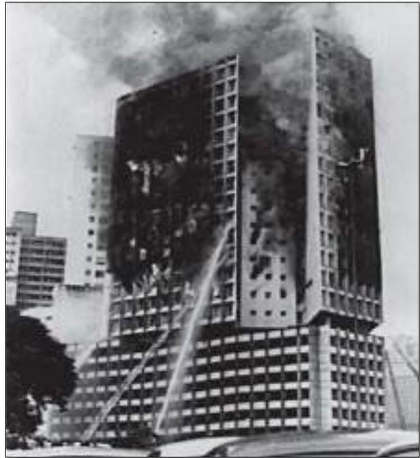
**Figura 13** – Propagação por condução (contato direto das chamas)
