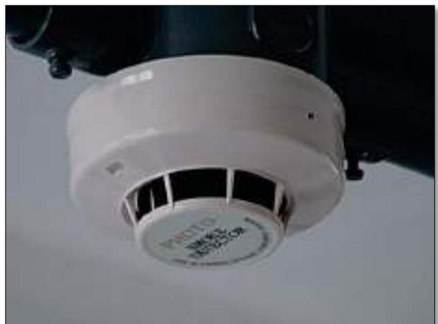
**Figura 41** – Detector de incêndio
