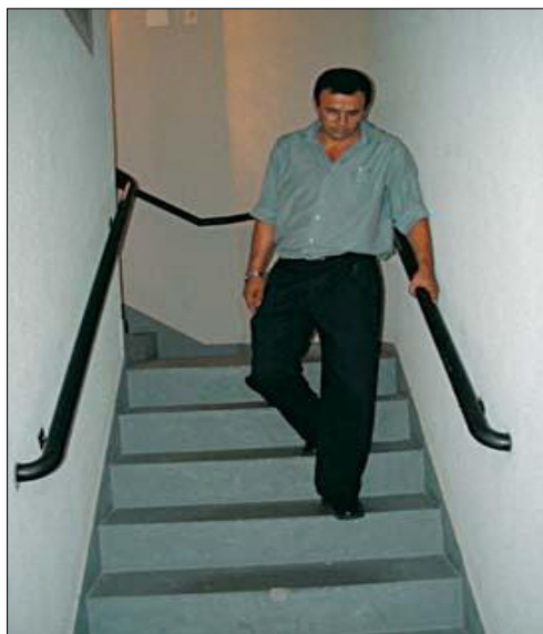
Figura 30 – Escada com largura apropriada para saída das pessoas
