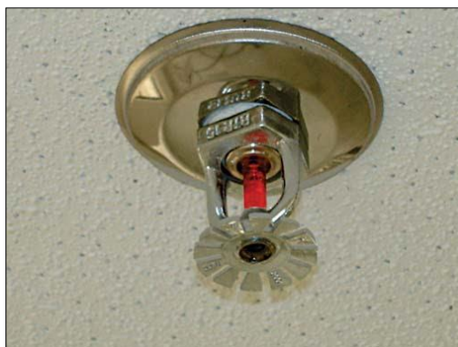
Figura 52 – Chuveiro automático
