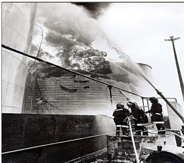
Figura 54 – Incêndio em parque de tanques
