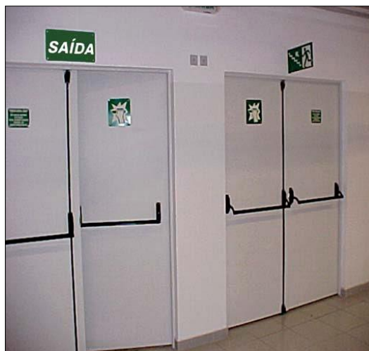
Figura 37 – Porta com barra antipânico
