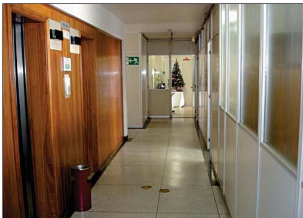
Figura 34 – Corredor desobstruído e sinalizado
