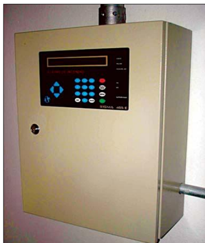
Figura 44 – Central de alarme
