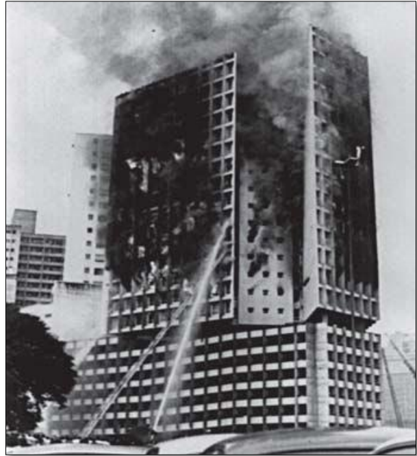
Figura 13 – Propagação por condução (contato direto das chamas)
