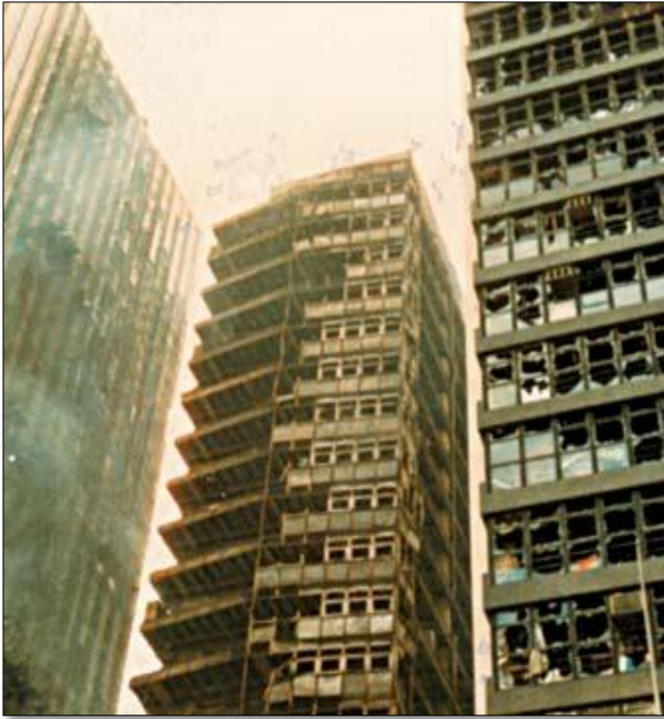
Figura 15 – Radiação de calor de um edifício para outro
