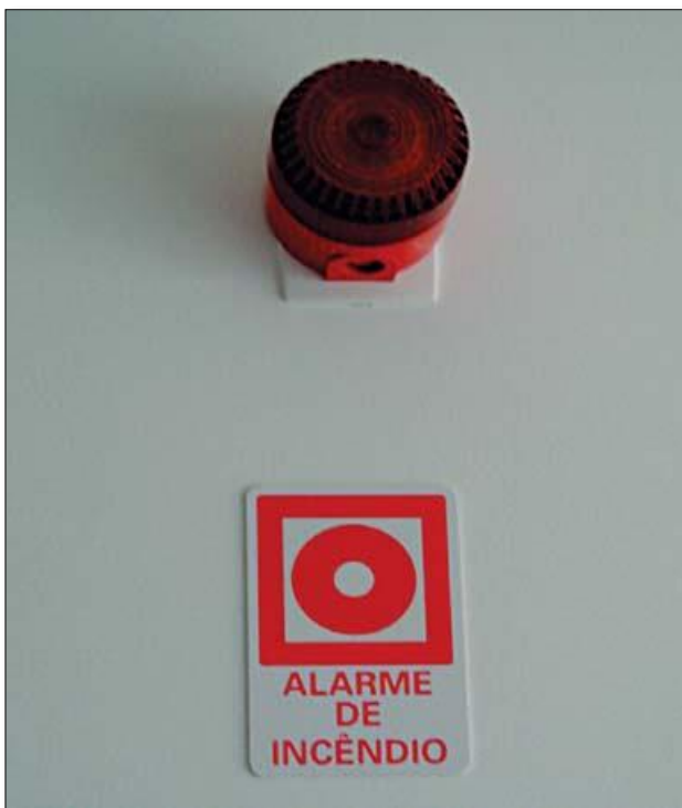
Figura 43 – Detalhe de sirene
