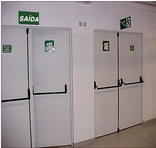
Figura 37 – Porta com barra antipânico
