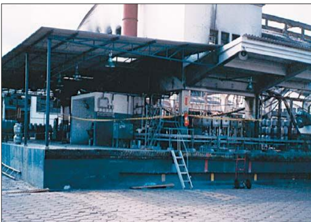
Figura 7: Isolamento do local sinistrado
