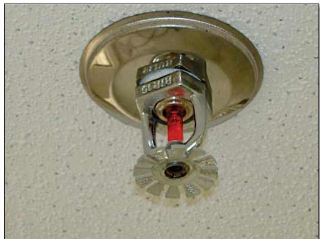
Figura 52 – Chuveiro automático
